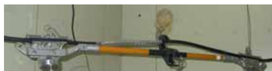
写真 1 切り分け工法による直線接続
